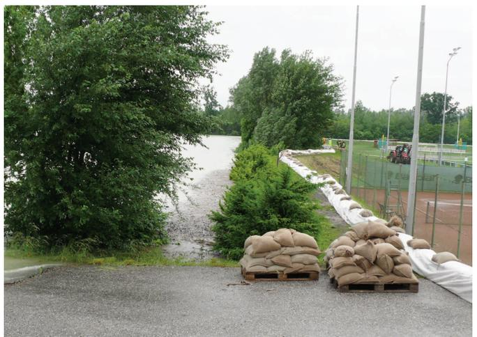
*Die Dämme wurden sicherheitshalber erhöht.*
