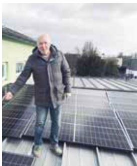
Unermüdlicher Umweltgemeinderat und GGR Manfred Bichler auf dem Dach des Bauhofes bei der Montage der PV-Anlage
